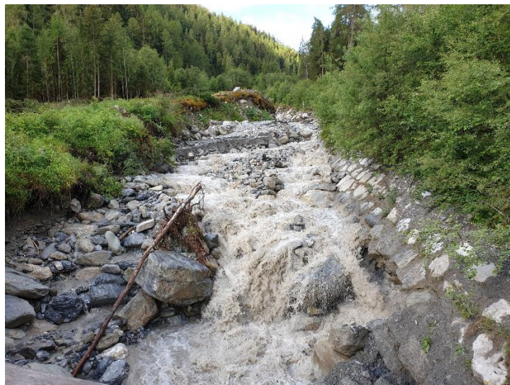
Schutzdamm Multa da Vau
